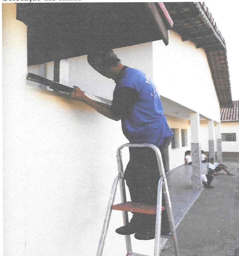
Colocação das calhas
